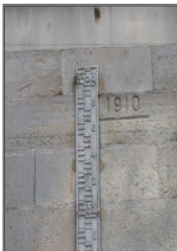
ci-contre un repère de crue (1910) accolé à une échelle limnimétrique
